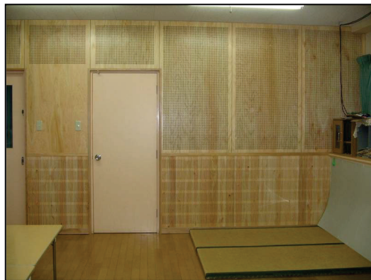
図2 音響改修後の壁面(室B)
