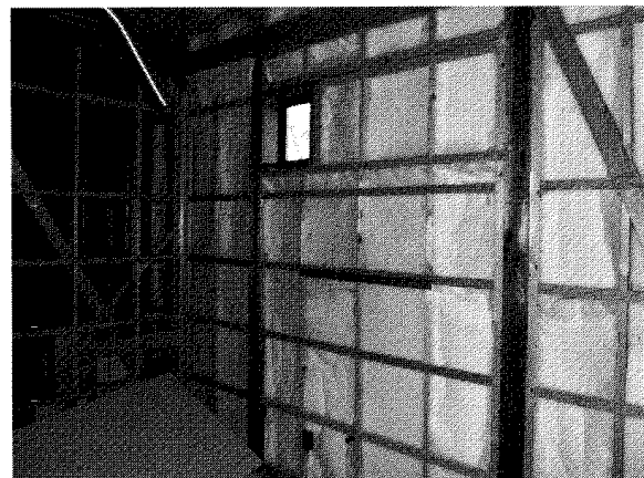
図4 PWを外壁2重壁の中空層に断熱材として施工した例
